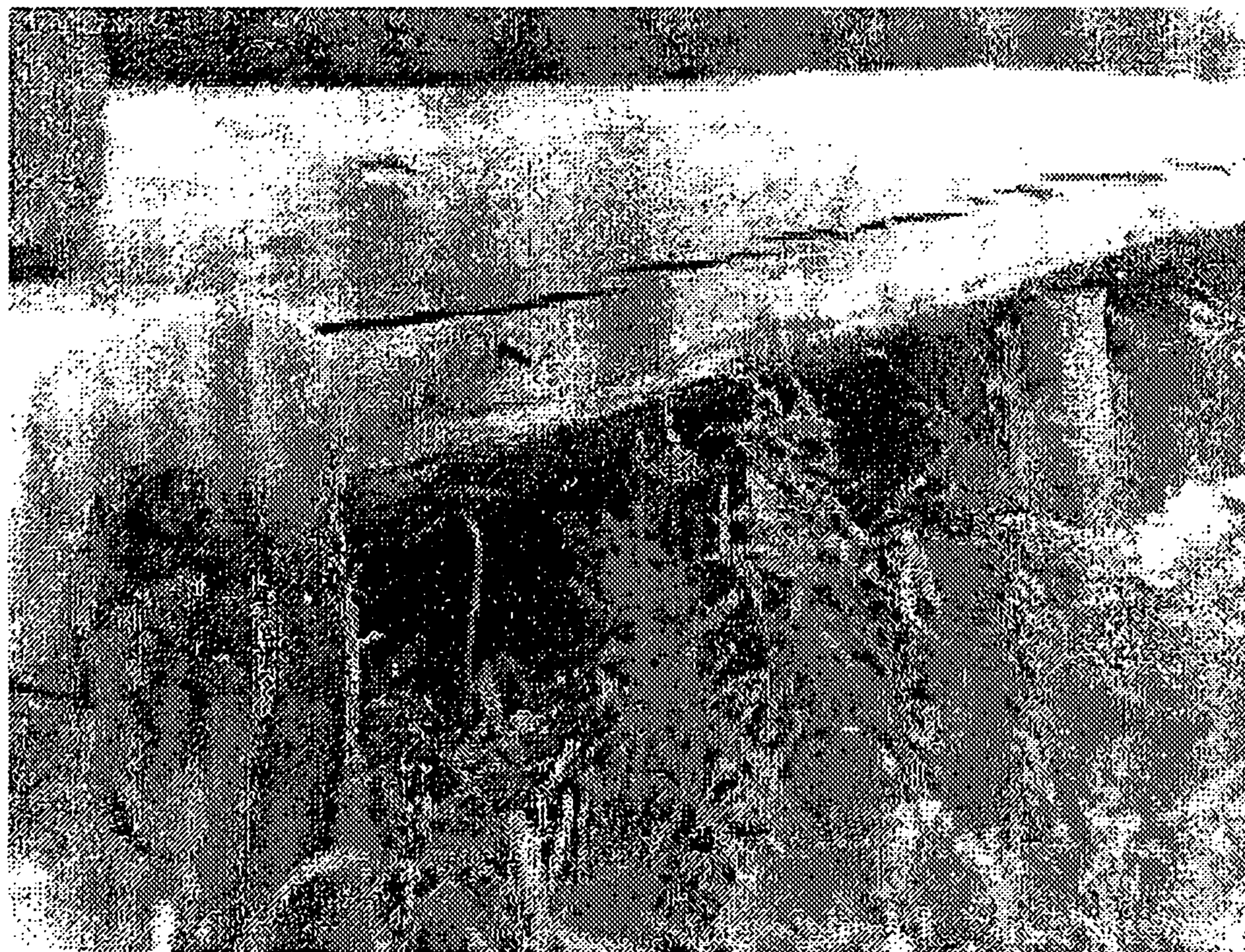
Фото 3. Амбар. Установка сруба на лиственные тумбы. Алтайский р-он
